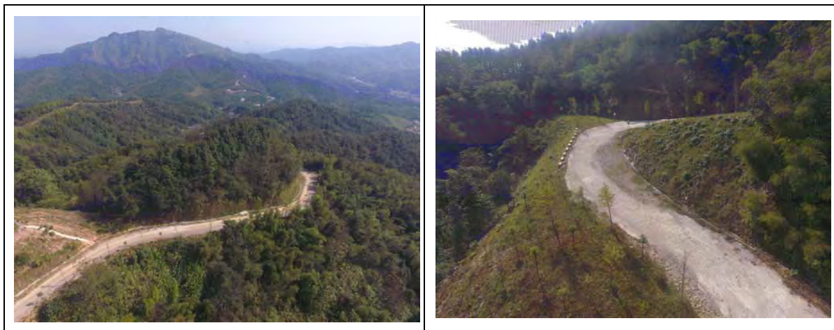
西区进场道路防护
