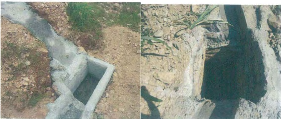
(6) 完成东片区道路排水系统整改
