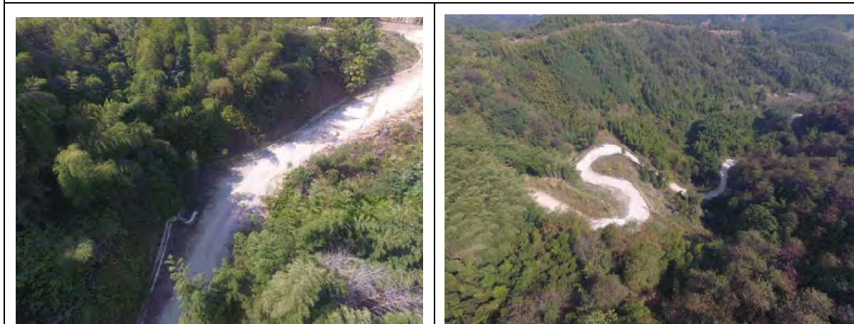
西区进场道路防护
