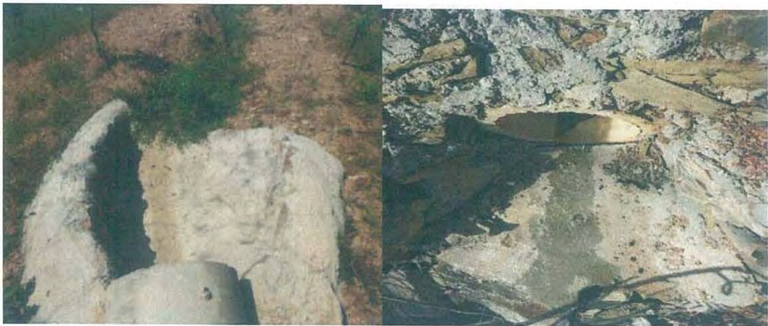
(5) 完成沉沙池、消能设施整改
