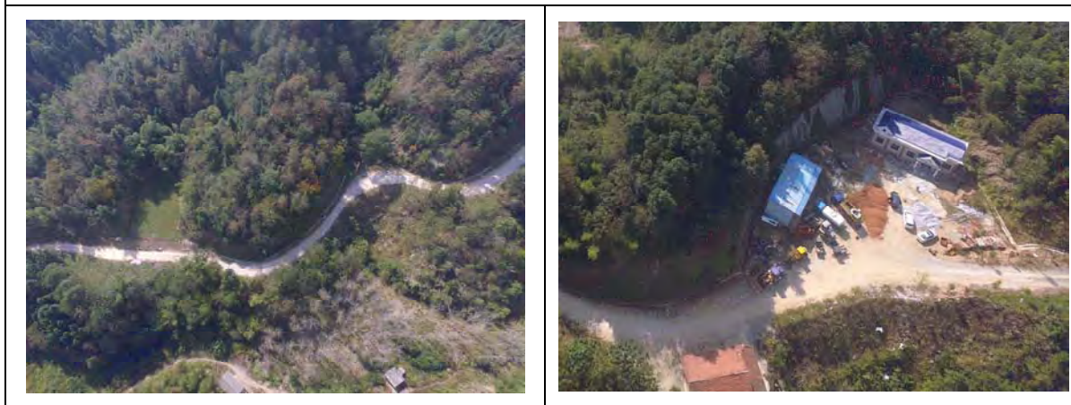
西区进场道路防护
