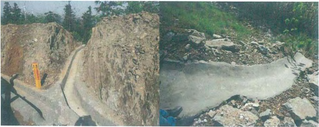
(4) 完成部分道路排水涵管整改
